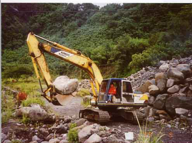
土石流發生後，立即對中斷的逃生路線做簡易的搶修
