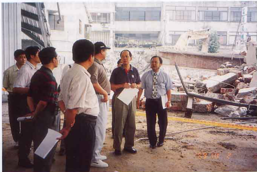
農委會彭主委（右二）實地勘查農業受損嚴重的苗栗縣卓蘭鎮，該鎮農會總幹事詹梁丙（右一）說明市場管理大樓倒塌情形
