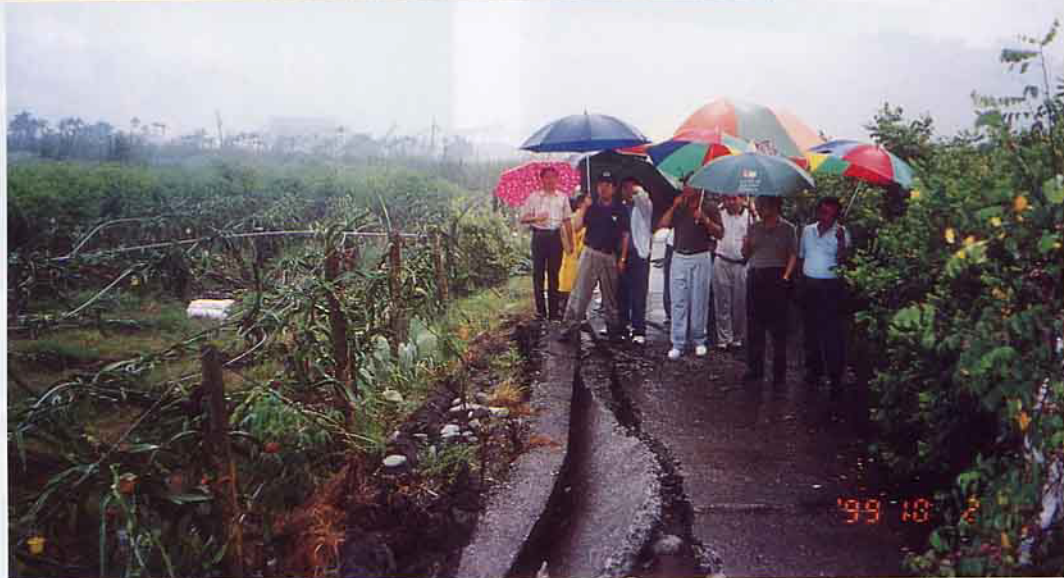
內灣里一帶受地震影響，地層鬆動，有嚴重的龜裂、隆起及位移等現象
