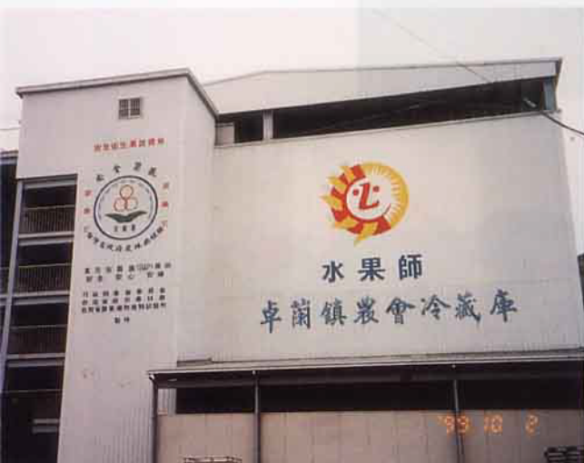
受地震影響，致這座冷藏庫冷凍管線破裂，氨氣外洩
