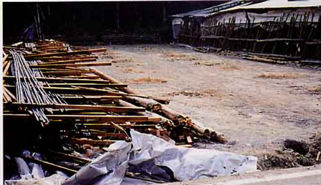
倒塌待重建的菇寮
