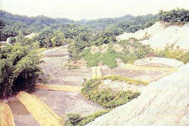
泥岩地區利用土堤配合植生之整治工法
