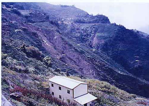
單戶散居陡坡上，其安全堪慮，應有危機意識
