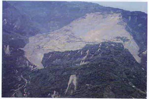
道路邊坡農地之崩場地
