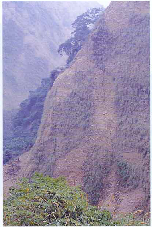
地震造成之崩塌地仍有再崩塌之可能（中間偏右係地震造成之張力裂縫）
