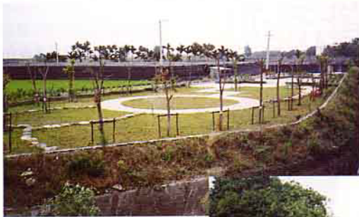
灌渠週邊綠美化工程
