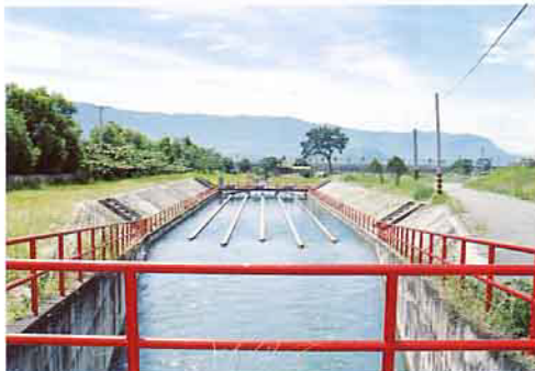
池上圳沉砂池
