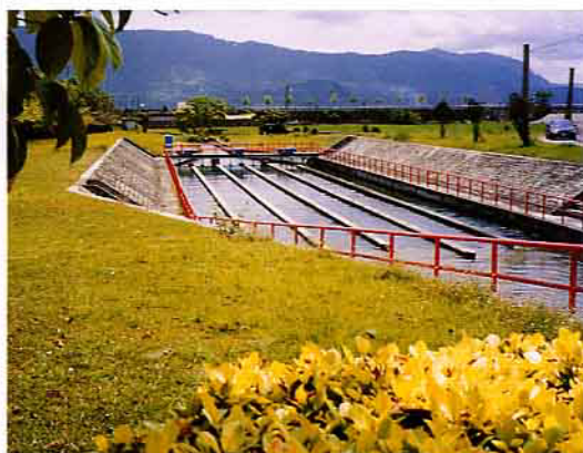
池上圳進水口沉砂池
