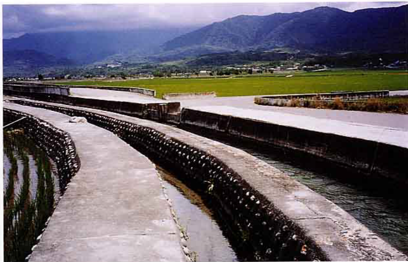
池上圳幹線渠道更新改善後現況
