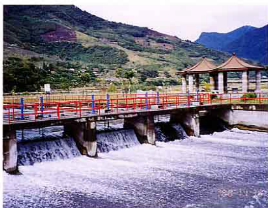
關山圳進水口沉砂池
