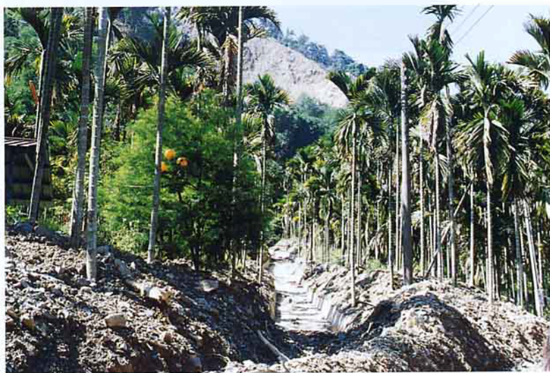
九芎林一帶土石流危及村民安全，水土保持局已進行緊急處理工程
