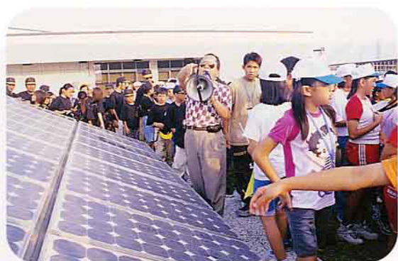
火力發電廠的“太陽能發電”設備
