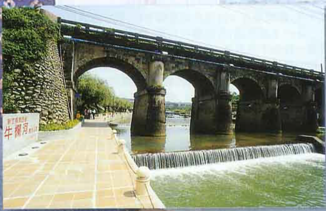
新竹縣關西鎮牛欄河親水、生態性水土保持工程
