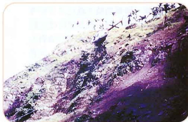
航空撒播施工
