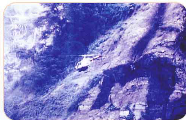
航空噴植施工
