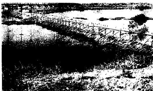
50年至70年代曹公圳進水口，引水方式為竹柵臨時欄水壩（曹公圳為大高雄地區農業用水命脈，創設於1837年道光十七年，後人應飲水思源）
