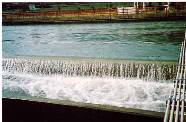
灌溉取水口設大型沈砂池沈砂，防止砂石流入灌溉渠道
