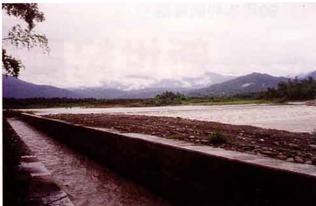
灌溉用水80%取自河川為安定取水，設置固床工發揮功能
