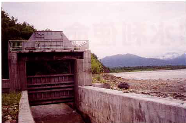
自河川取水，以重力送水供灌溉使用
