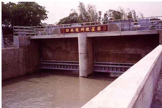
台中農田水利會921震災重建—葫蘆墩圳進水口工程
