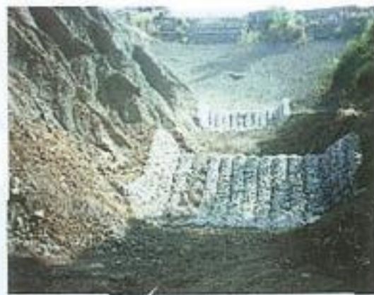
圖14 箱籠鋪石固床工
