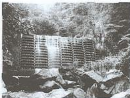
圖10 鋼筋混凝土格龍潛堤
