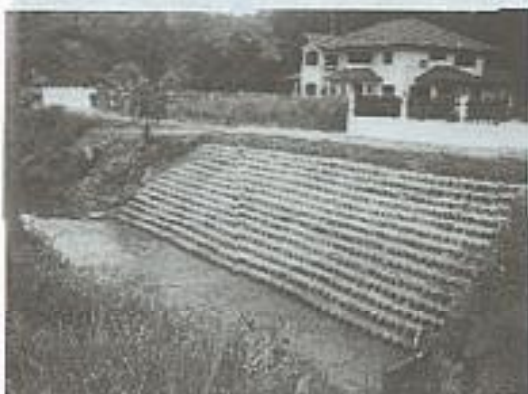
圖8 蜂巢圓束網格堆疊護岸
