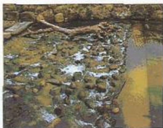
圖13 階梯式混凝土鋪石固床工3
