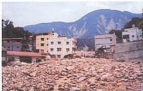
上安村土石流災害
