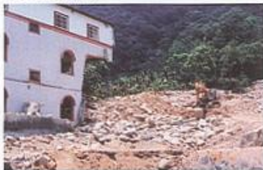
地利村土石流災害
