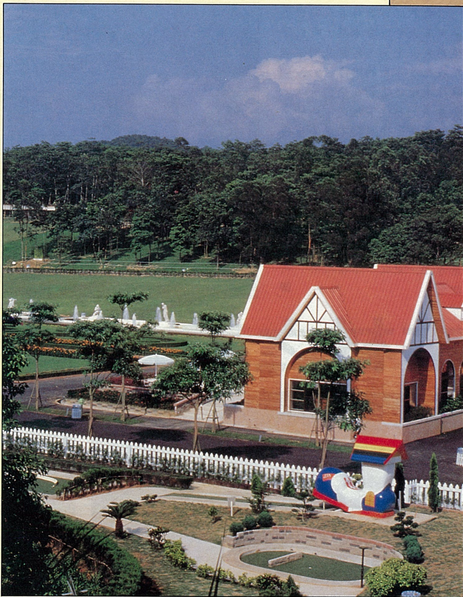
國內大型休閒木屋的設計，應留意結構安全與精準度問題。
