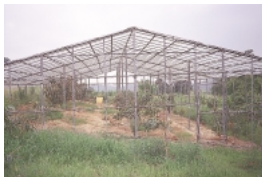
簡易遮雨棚可防炭疽病的發生
