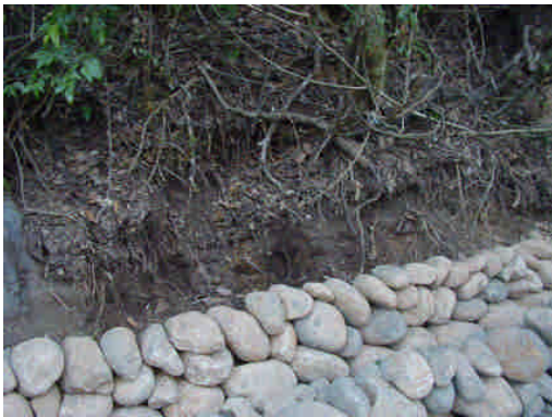
照片 5-1 現況照片
