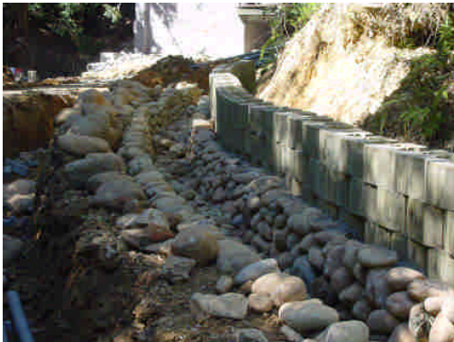
照片 4-19 工地現況照片
