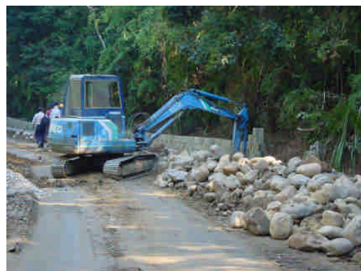
照片 5-14 現況照片
