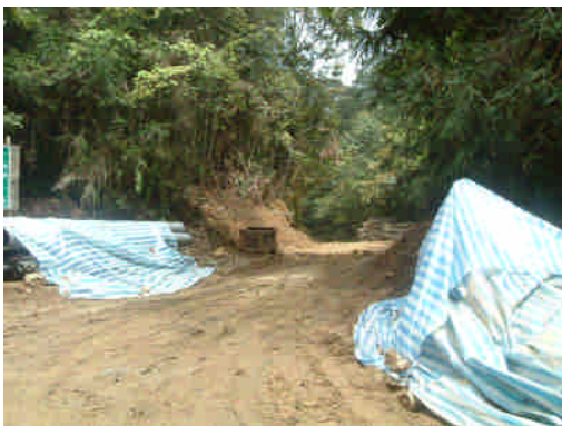
照片 4-13 施工前現況照片
