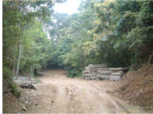
照片 4-12 施工前現況照片
