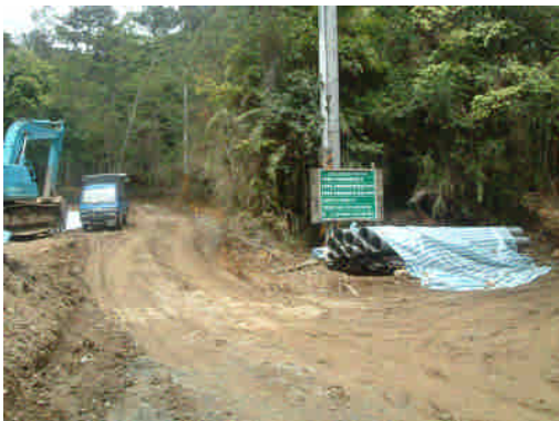
照片 4-15 施工前現況照片
