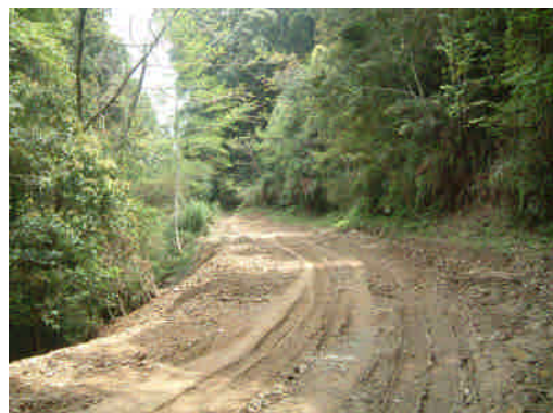
照片 4-16 施工前現況照片
