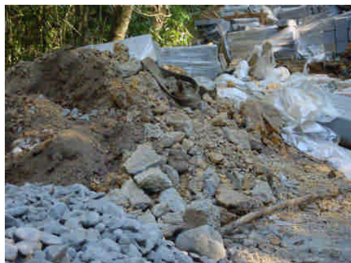
照片 5-12 現況照片
