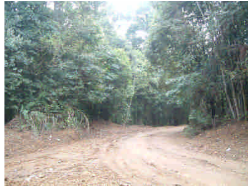
照片 3-4：遊憩區道路現況
