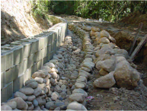
照片 4-17 工地現況照片
