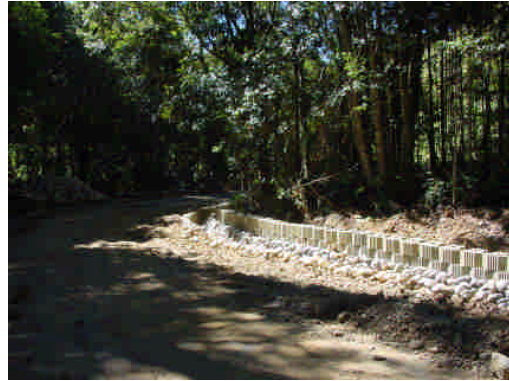
照片 4-18 工地現況照片
