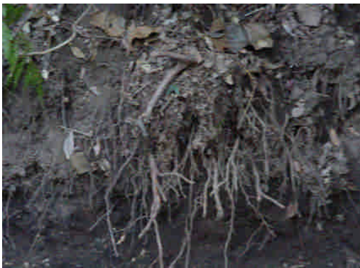
照片 5-5 現況照片
