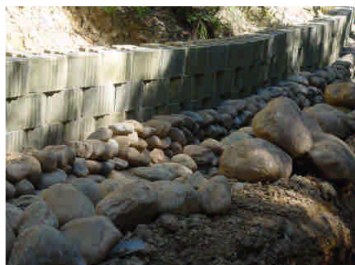
照片 4-20 工地現況照片
