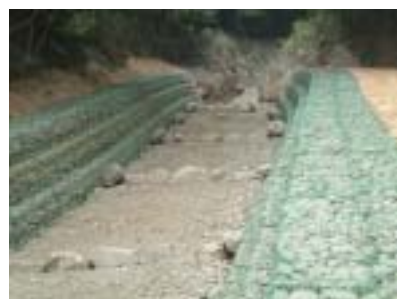
圖 5-15 上邊坡排水路
