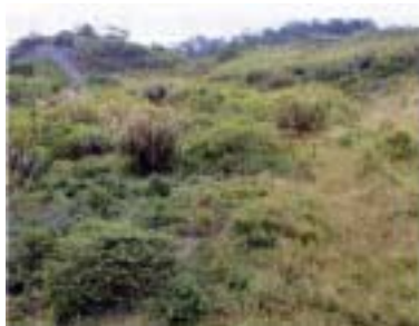
圖 5-1 邊坡植生工法
