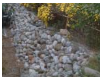
圖 5-9 塊石疊砌穩定邊坡
