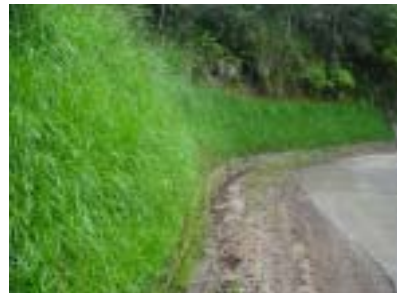
圖 5-2 邊坡植生工法
