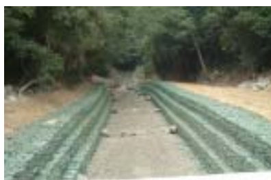
圖 5-14 上邊坡排水路
