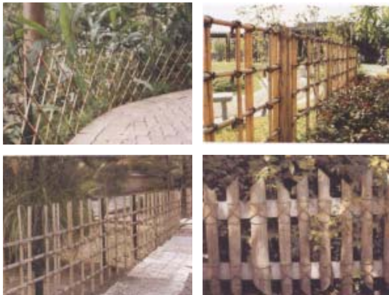
圖 5-28 運用當地材質(竹子)作為小路徑之景觀護欄
