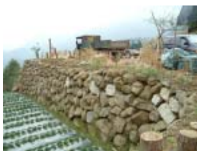
圖 5-8 塊石疊砌穩定邊坡
