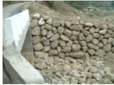
圖 5-17 下邊坡出水口
