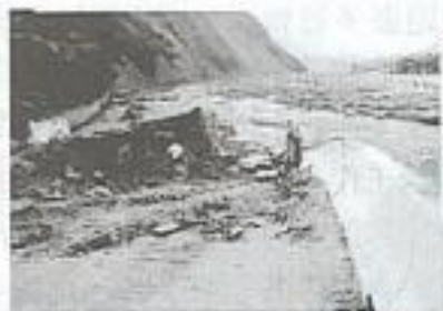
◀ 信義鄉陳有蘭溪橋原址，只剩下殘破的道路，橋梁完全消失
