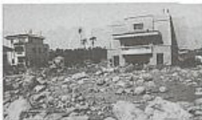
竹山木曜寮莊的豪宅被土石圍困在溪床中
