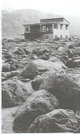
竹山鎮加走寮溪湧出大量巨石，一棟別墅陷入巨石群裡
