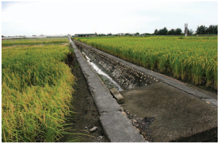
規劃完整的農田水利建設
