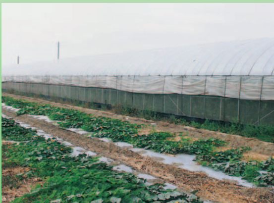
搭建的溫（網）室設施
