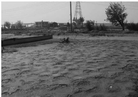
池塘堆積大量污泥，應將污泥挖除
