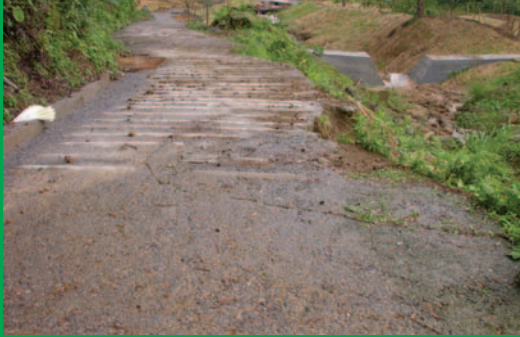
A. 野溪旁上游步道邊坡不安定區弧形頭部是泥沙來源之一
