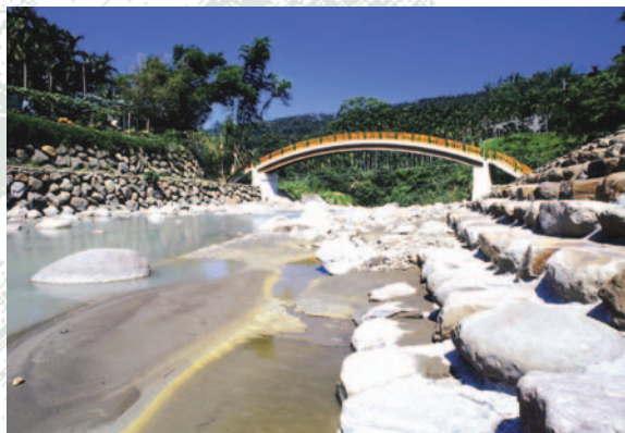
南投中寮鄉清水村—生態野溪整治兼休閒設施
