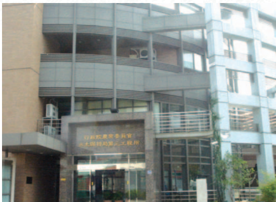
第三工程所建築外貌
