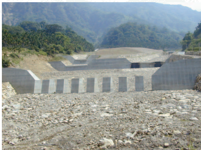
南投縣水里鄉三部坑梳子壩
