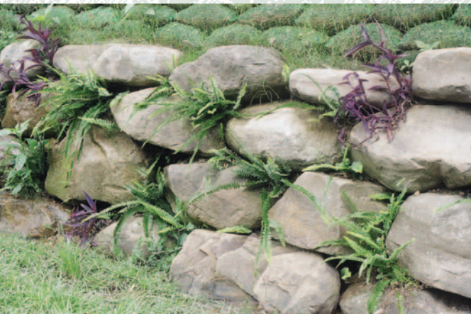
崩塌地基腳以砌石構築，營造多孔隙棲息環境
