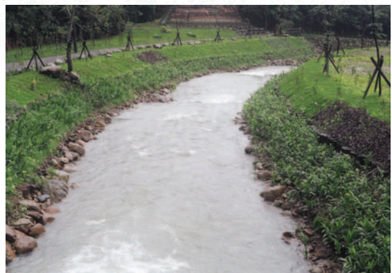
施工後—后番子坑溪整治後河岸穩定，綠意盎然
