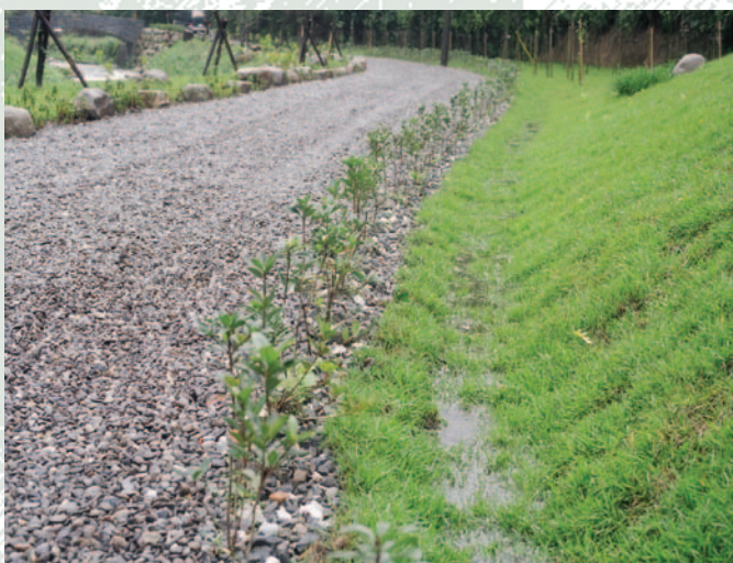
拱形砌石固床工形成湍瀨、深潭，流水聲誘導魚蝦棲息回游，及透水性佳之級配步道與草溝
