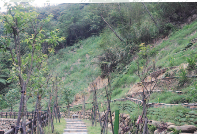
崩塌地採複式階段穩定邊坡之工法設計，完成後成為休閒賞魚步道
