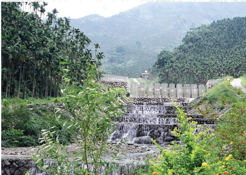
土石流以近生態工法整治
