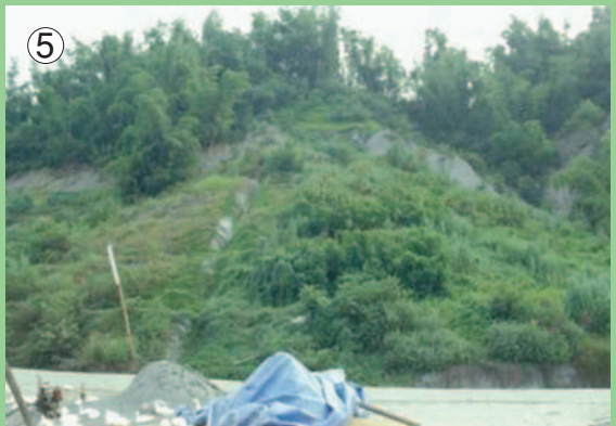
⑤ 田寮農塘試驗區植生試驗邊坡 2 年後邊坡覆蓋情形 (陳振盛於 1994 年拍攝)
