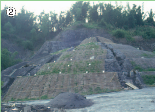
② 田寮農塘試驗區植生試驗邊坡施工情形 (陳振盛於 1992 年拍攝)
