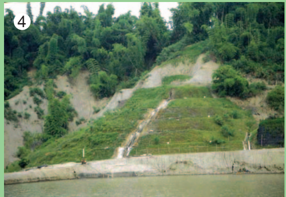
④ 田寮農塘試驗區植生試驗邊坡 1 年後邊坡覆蓋情形 (邱創益於 1993 年拍攝)
