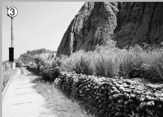
南二高田寮收費站南下邊坡(圍堵法)情形 (2005 年 7 月拍攝)
