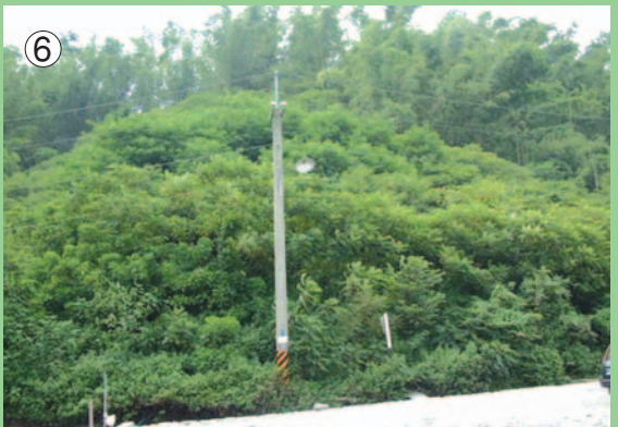
⑥ 田寮農塘試驗區植生試驗邊坡 8 年後邊坡覆蓋情形 (2001 年拍攝)
