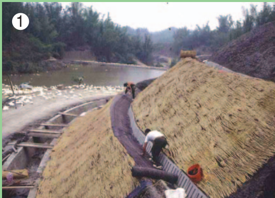
① 田寮農塘試驗區植生試驗邊坡施工情形 (邱創益於 1992 年拍攝)
