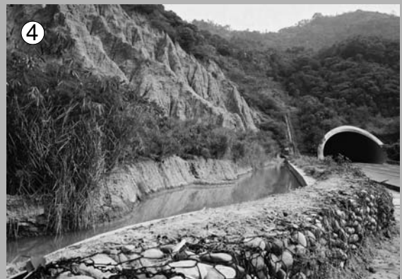
南二高田寮收費站南下隧道口陡峭裸坡坡腳下方圍堵沉砂區清淤後情況 (2005 年 10 月拍攝)
