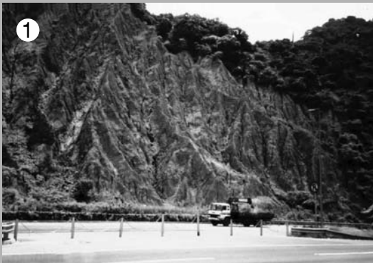
南二高隧道口陡峭坡腳土堤圍堵法 (邱創益於 2003 年 8 月拍攝)
