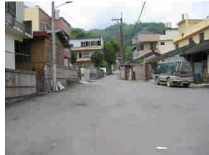
圖 3-86 中間部落街道全景
