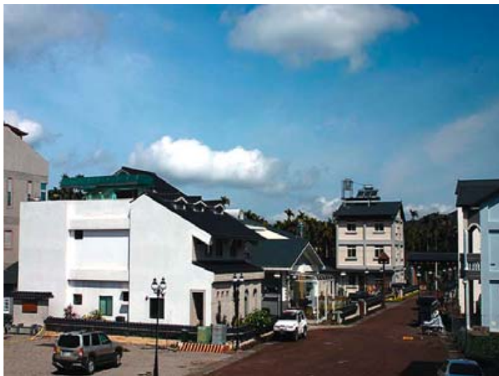
南投縣魚池鄉共和村長寮尾聚落重建
