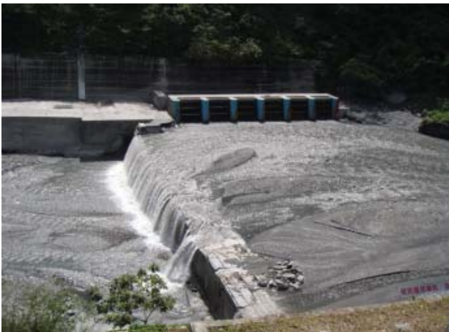
農業灌溉用水取水設施-卑南上圳取水口全景
