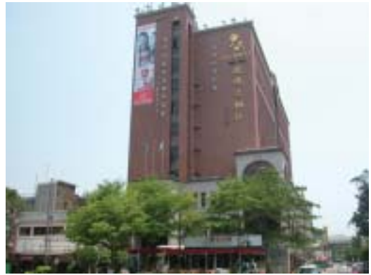
水利會大樓利用建築物及外牆出租之多角化經營 (新竹農田水利會范綱翰先生提供)
