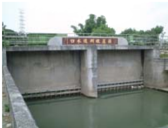
台中農田水利會葫蘆墩圳更新改善工程
