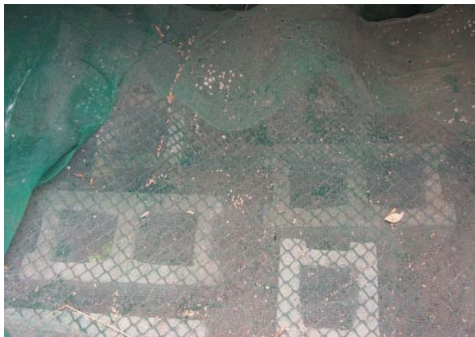
堆肥箱底部空心磚應交錯置放，以提高龜殼網對堆肥體之承受力
