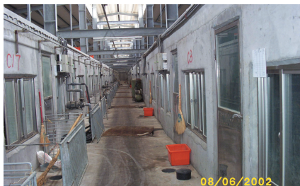
保育舍採負壓式設計，溫度自動控制
