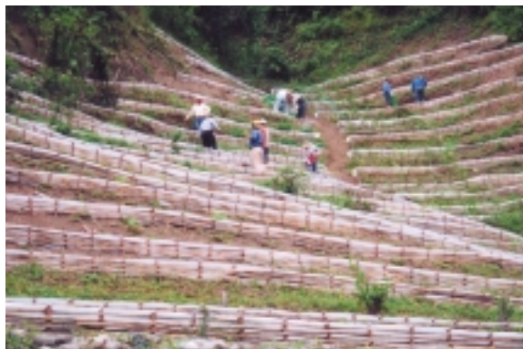
治山防災工程現場
