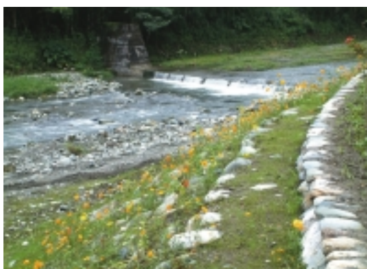
整治後的野溪，減少土石流的發生
