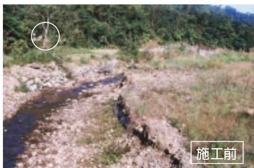
神農橋下游河道左右岸因降雨逕流，產生淘刷情形
