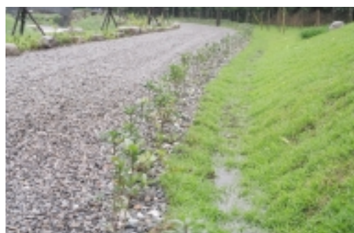
沿溪碎石生態步道及植生草溝，水性佳，有利降雨入滲及水資源存量
