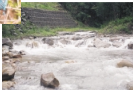
支流砌箱龍護岸
