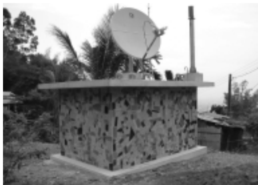
圖七 土石流觀測站
