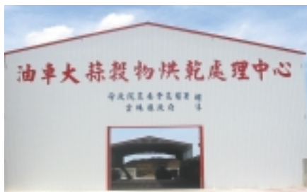
油車大蒜穀物烘乾處理中心
