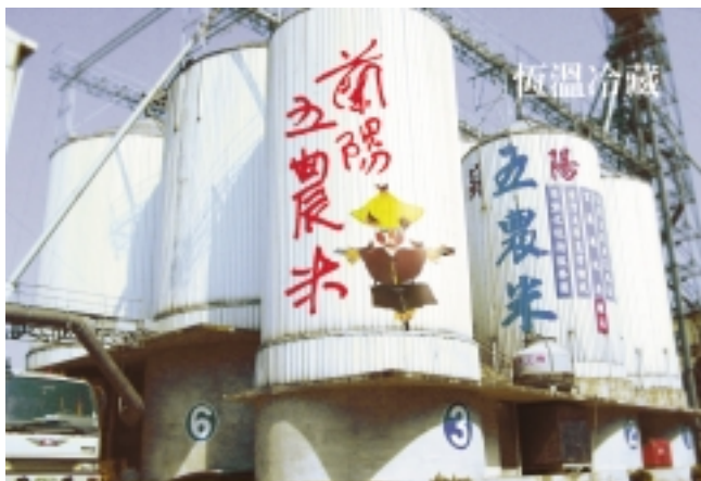
恆溫冷藏桶～把米的水分和養分緊緊鎖住(五結鄉農會提供)
