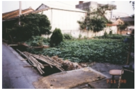
八方湧樂亭施工前
