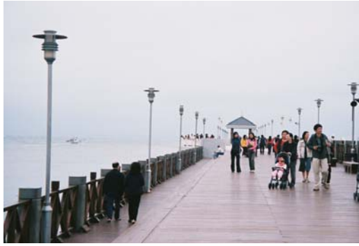
延伸入海的木棧道
