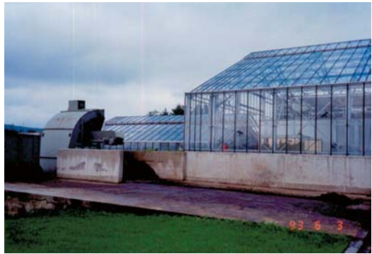
圖26 堆肥發酵室（內有批式發酵槽）
