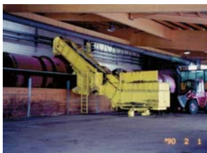
圖17 廢棄物裝入發儲槽
