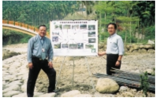
第三工程所第三課黃課長在現場向張所長說明工程進度情形
