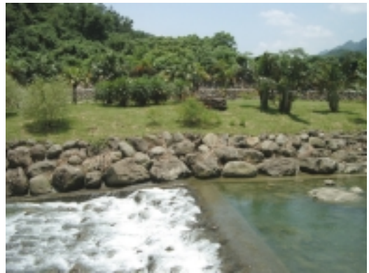
苗栗縣獅潭鄉新店溪整治工程
