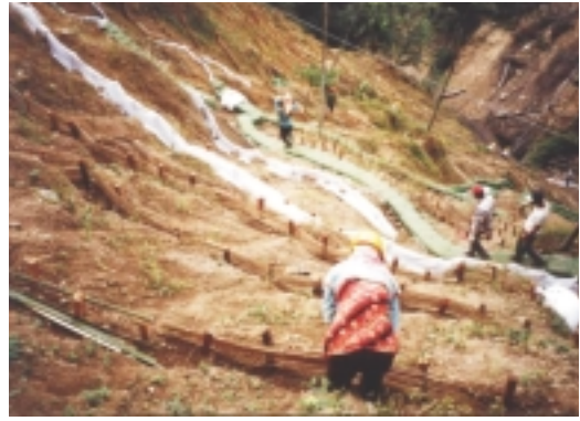
坡面打樁編柵（固定土石）
