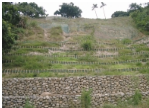
坡腳基礎穩定
