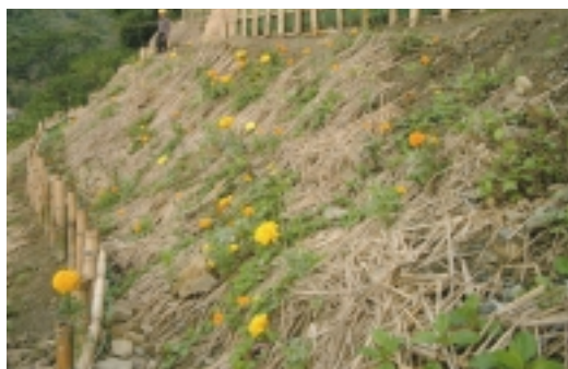
利用稻草蓆敷蓋坡面減少土壤沖蝕及固定撒播種子
