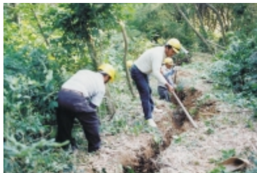
源頭裂縫填補
