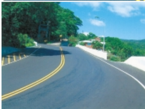
平溪產業道路拓寬改善工程
