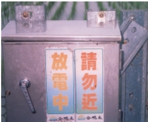
裝上自動控制間斷通電系統
